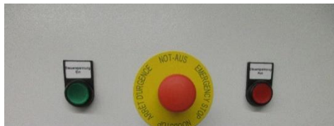
Ein-/Ausschaltung mit Not-Aus Schalter im Leitstand
