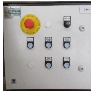
Vorortbedienung mit Not-Halt Schalter
