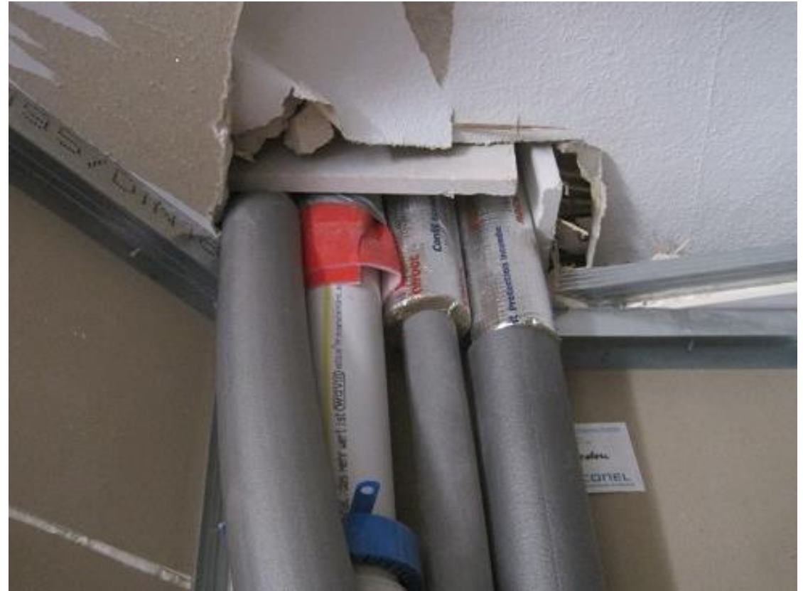
Bild: Pfeil Bauteilservice
