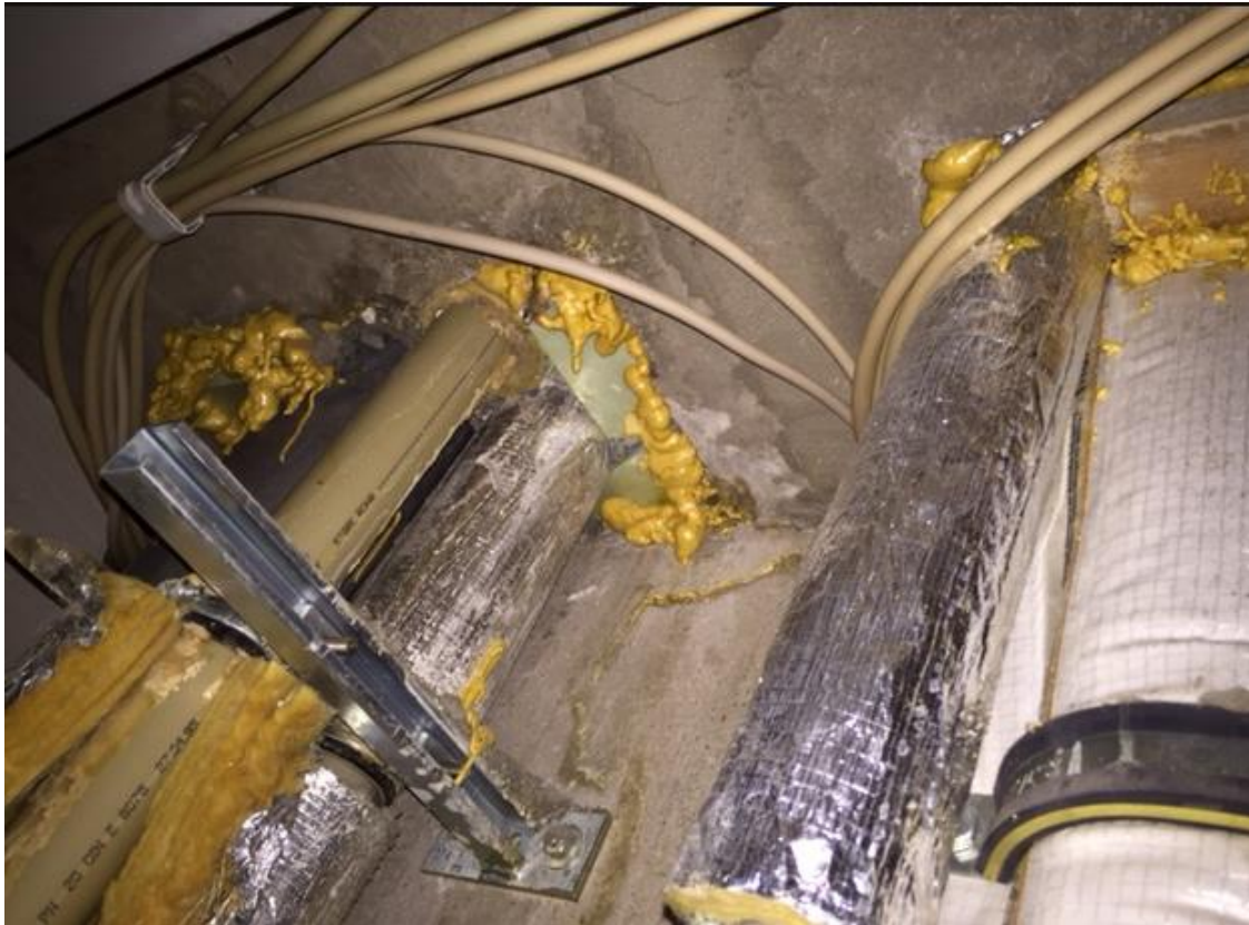
Bild: Pfeil Bauteilservice
