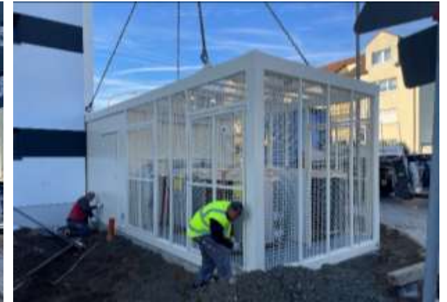
Modul auf Fundament Uhrzeit: 09:42 Uhr
