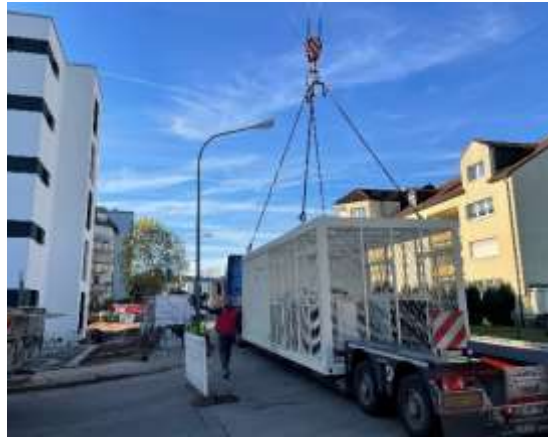
Einhaken des Moduls: Uhrzeit: 09:34 Uhr
