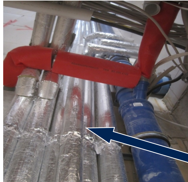
Foto Pfeil Bauteilservice
