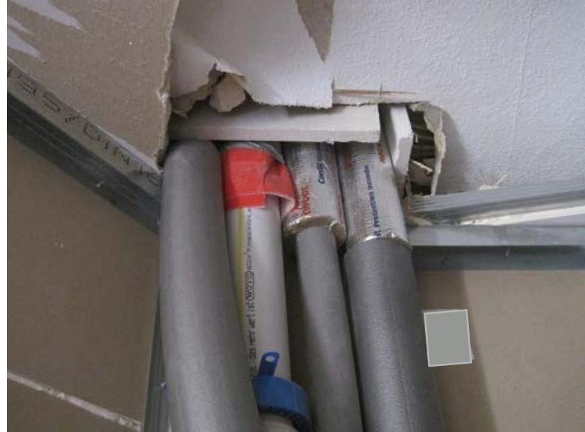
Bild: Pfeil Bauteilservice
